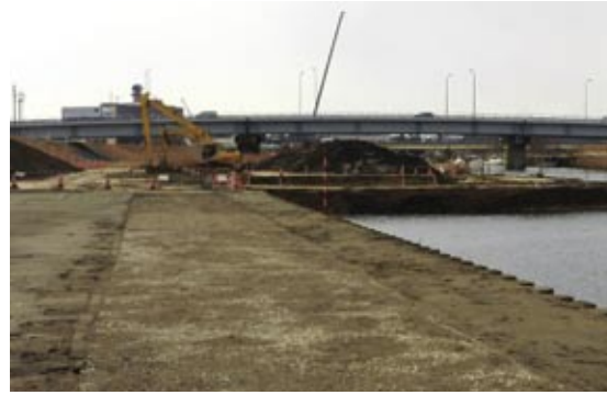
拡幅護岸工事中の梯川
